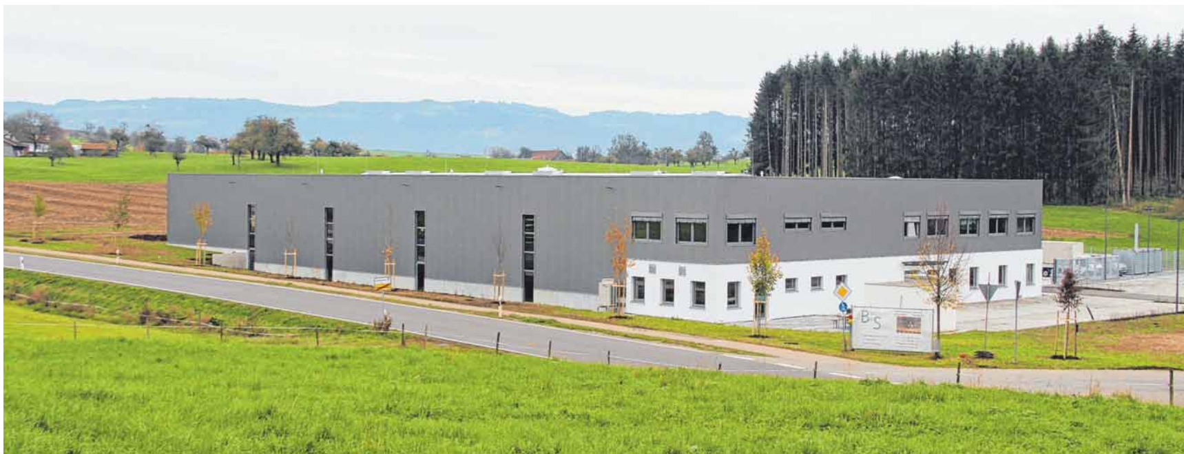
Die neue Produktionshalle der B & S Blech & Stahl GmbH befindet sich nun auf 6000 m² Fläche am Wattrain 1 in Achberg.
